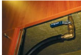
Lämpöaltaan tyhjennysventtiili
