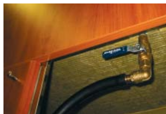
Lämpöaltaan tyhjennysventtiili
