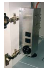
Lämpöaltaan virtakytkin ja termostaatti
