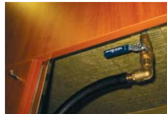
Lämpöaltaan tyhjennysventtiili
